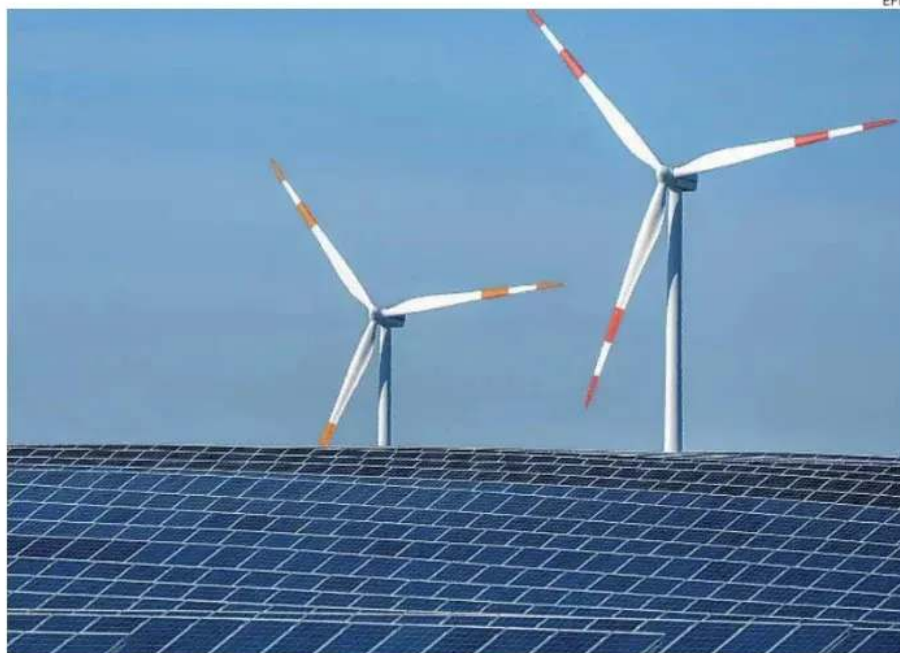
Planta híbrida eólica y fotovoltaica en España
